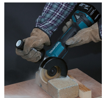
Tronçonnage avec carter d'aspiration raccorder à un aspirateur
